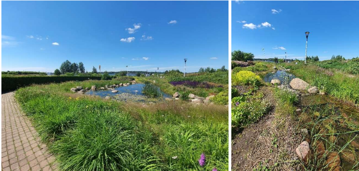
Kuva 18. Hulevesiuoman levennys, Katariinan Meripuisto, Kotka. Kuva: Zuzana Hrasko-Johnson.
